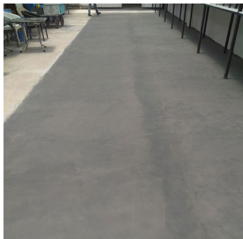
شکل ۵. اجرای پوشش مقاوم سیمانی ضد آب بر روی سطح بتنی افقی، تصویر سمت راست قبل از اجرا و تصویر سمت چپ بعد از اجرا Figure 5. Application of Water-Resistant Cement Plaster on a horizontal concrete surface (right: before application, left: after application)
